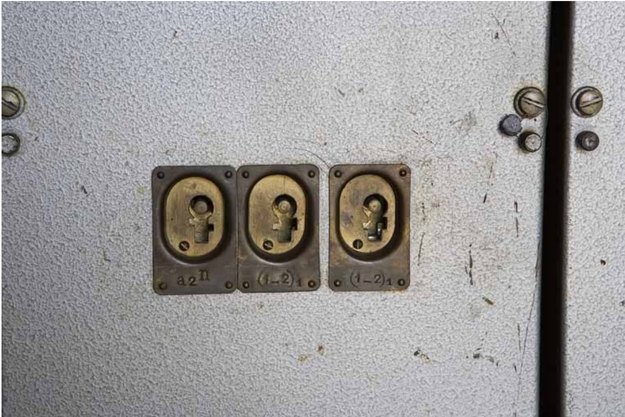
Bureau : serrures du transmetteur central.
