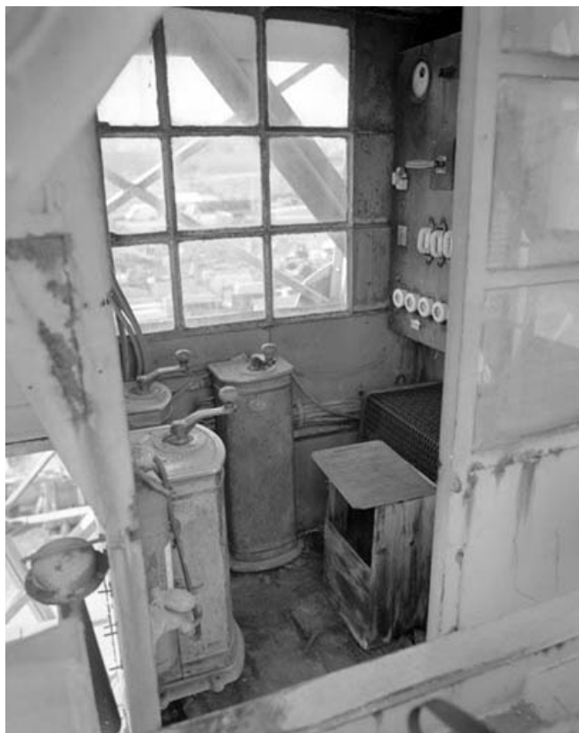
Intérieur de la cabine.
