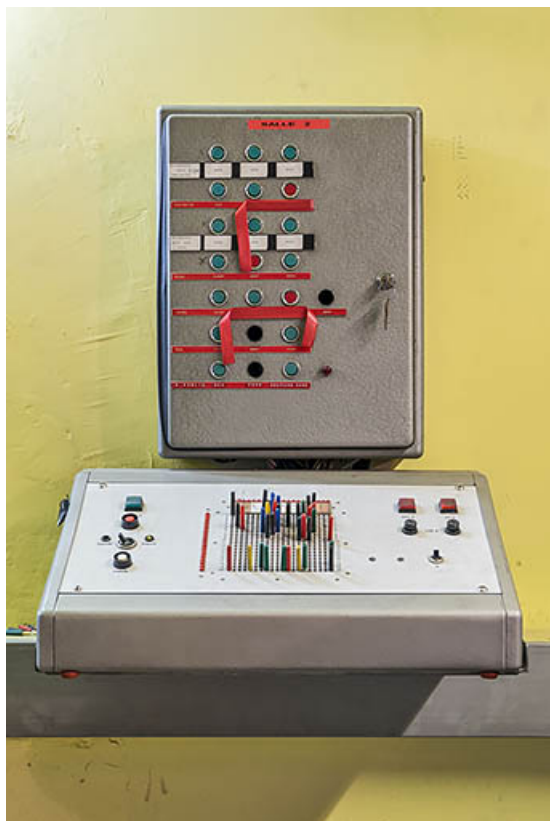
Pupitre à matrice à diodes et boîtier de commande à boutons poussoirs. 21, Dijon, 8 place Darcy
