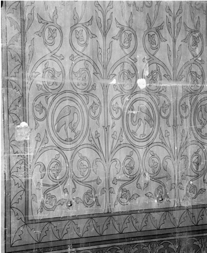
Choeur, mur nord (1991) : peinture monumentale.
