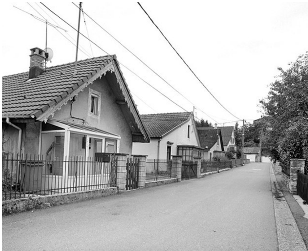
Alignement de maisons rue du Temple.
