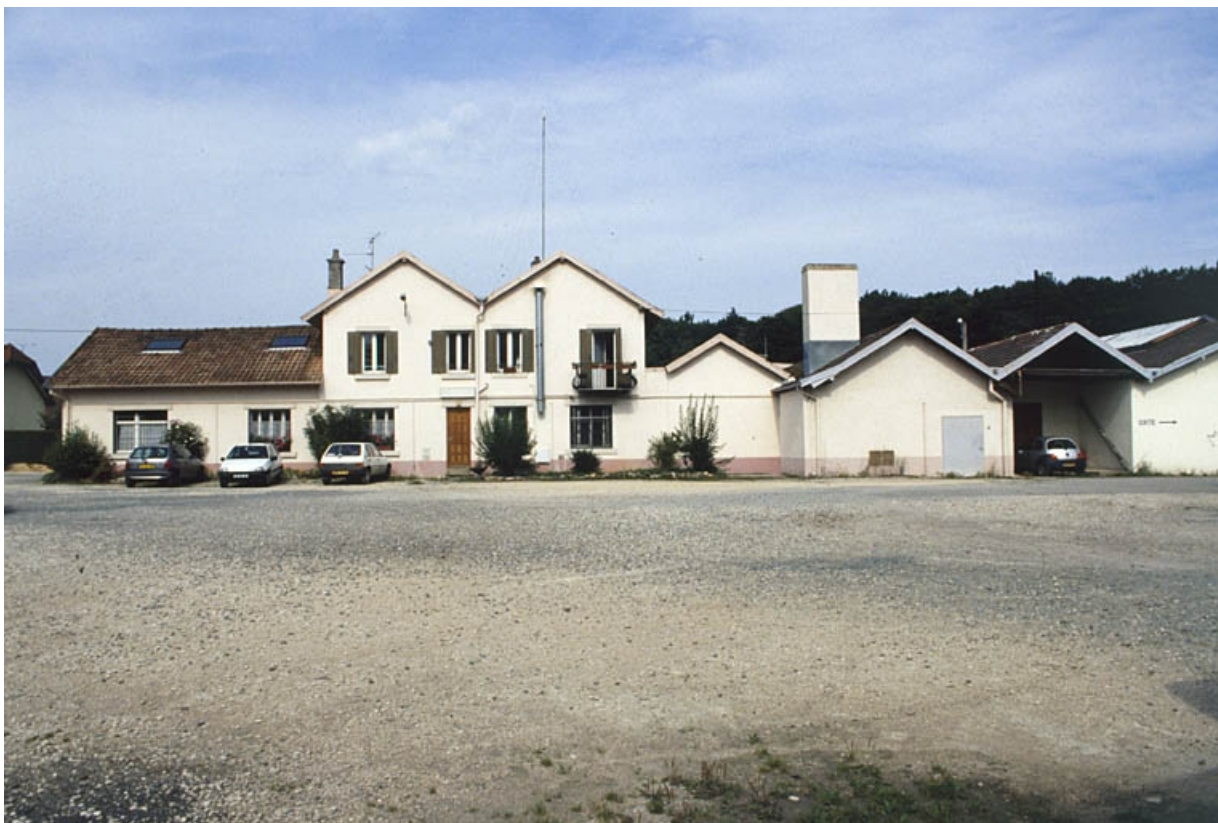
Façade postérieure des bâtiments sur rue.
