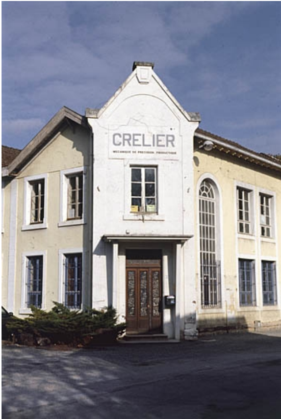
Bâtiment d'entrée : bureaux.
