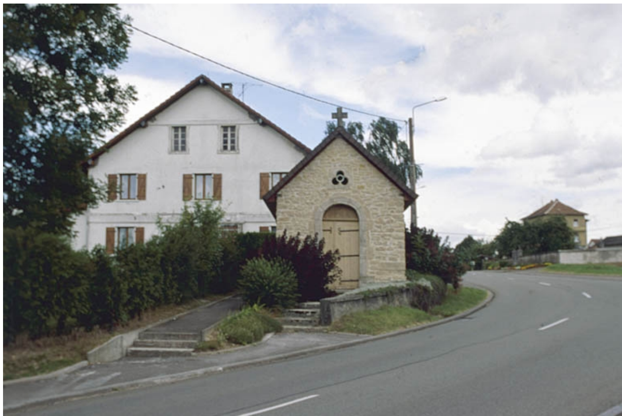
Mur-pignon sud du bâtiment : le logement.
