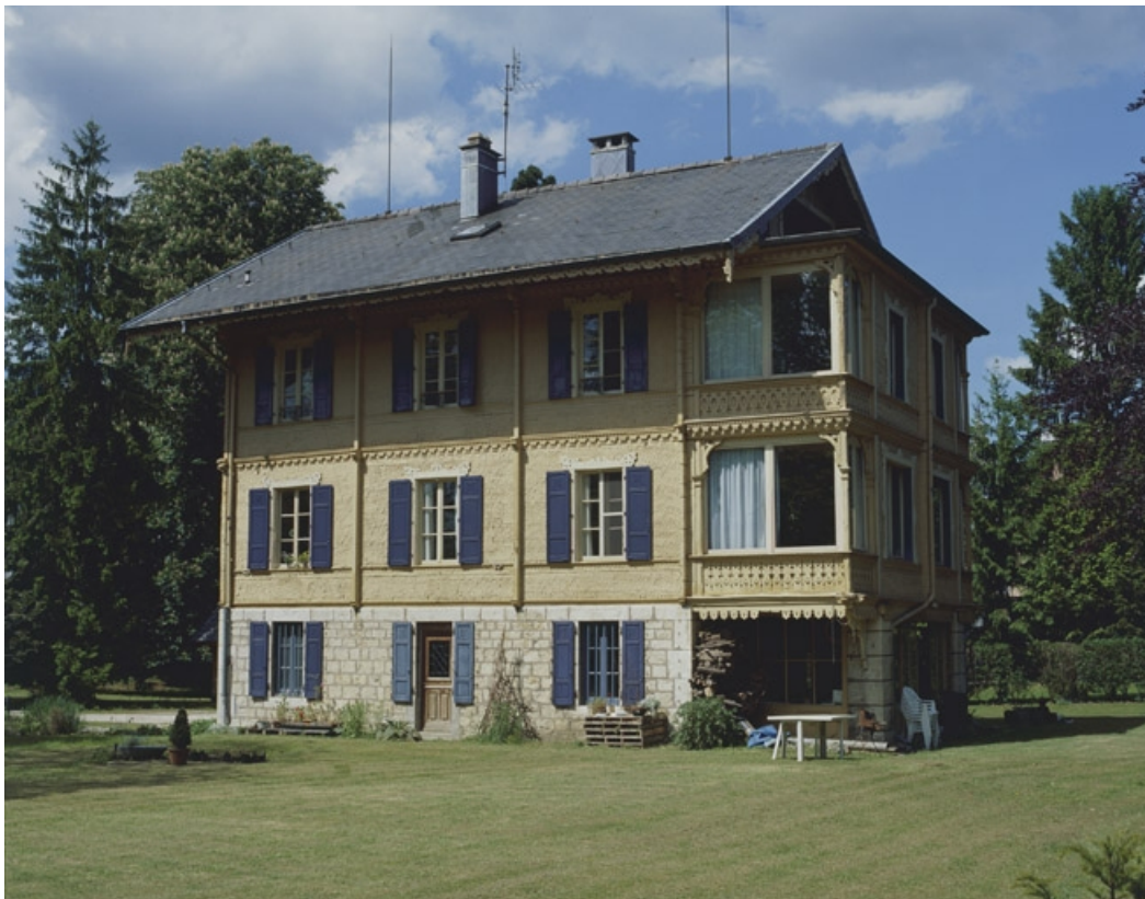
Chalet. Façade sud.
