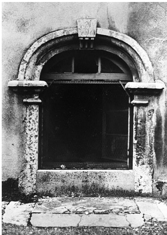
Baie sur la façade sud (état en 1978).
