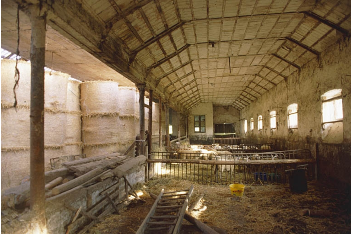
Travée sud de l'étable.
