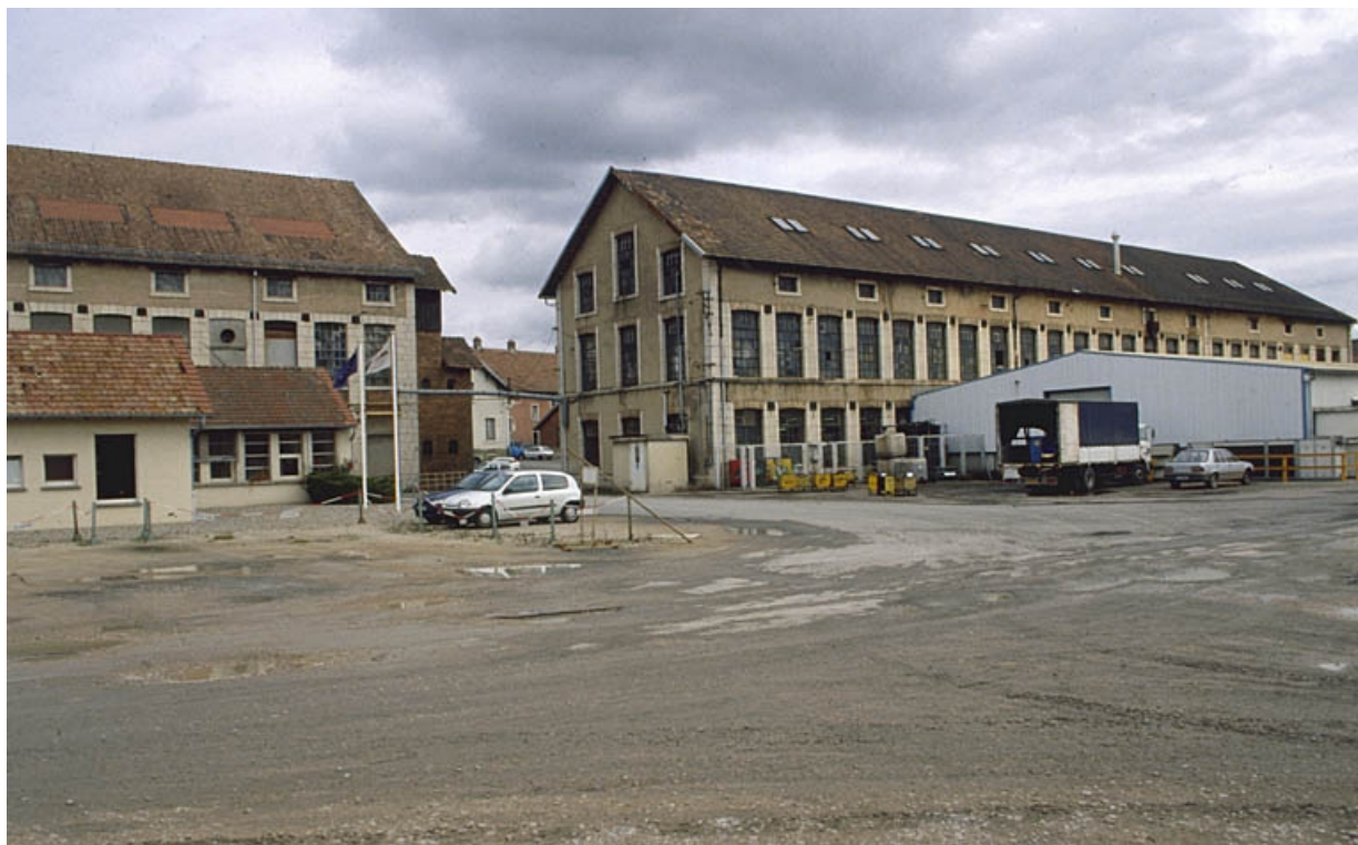
Ateliers de fabrication depuis l'ouest.
