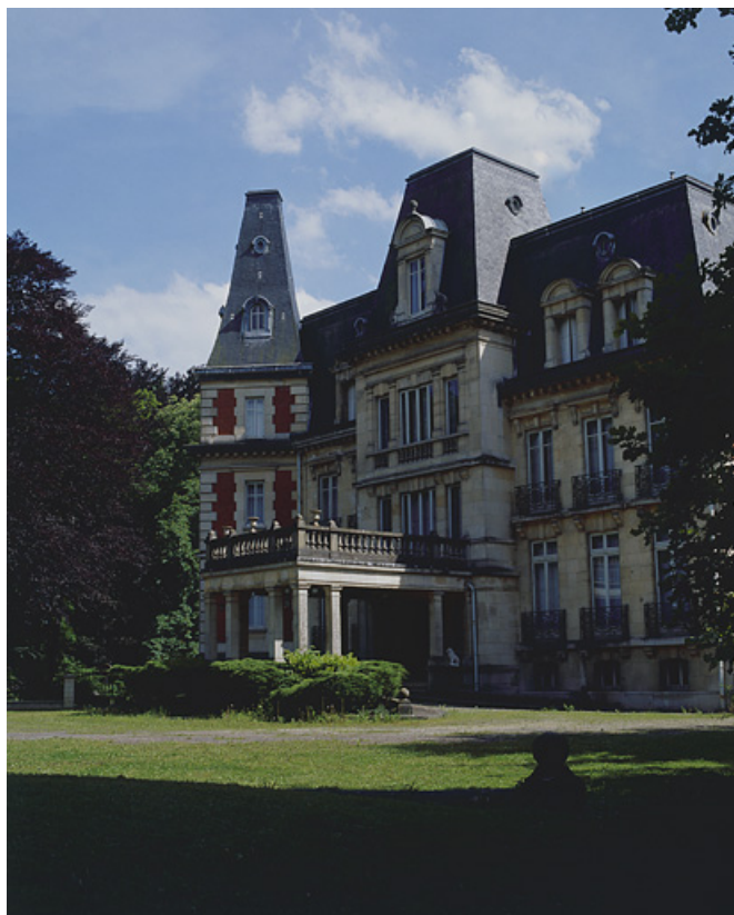
Façade nord vue de trois quarts.
