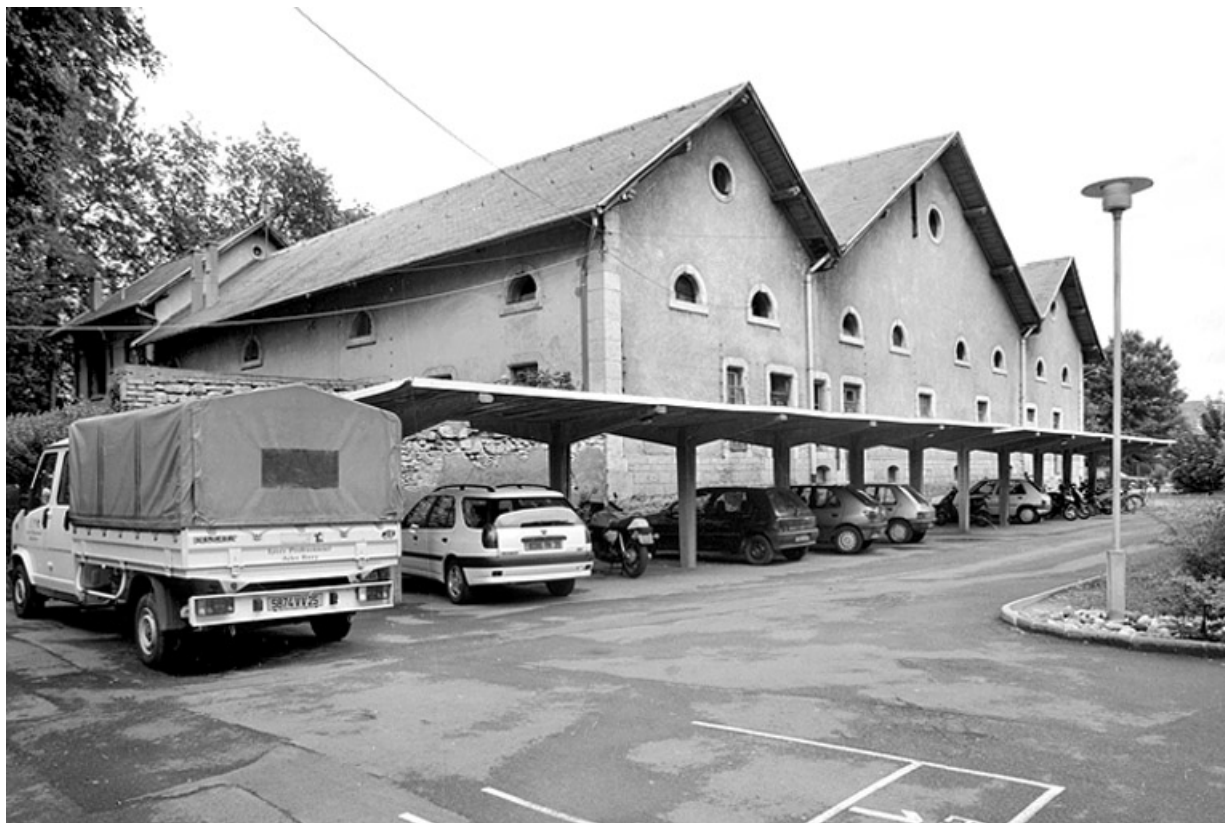
Façade postérieure des écuries.
