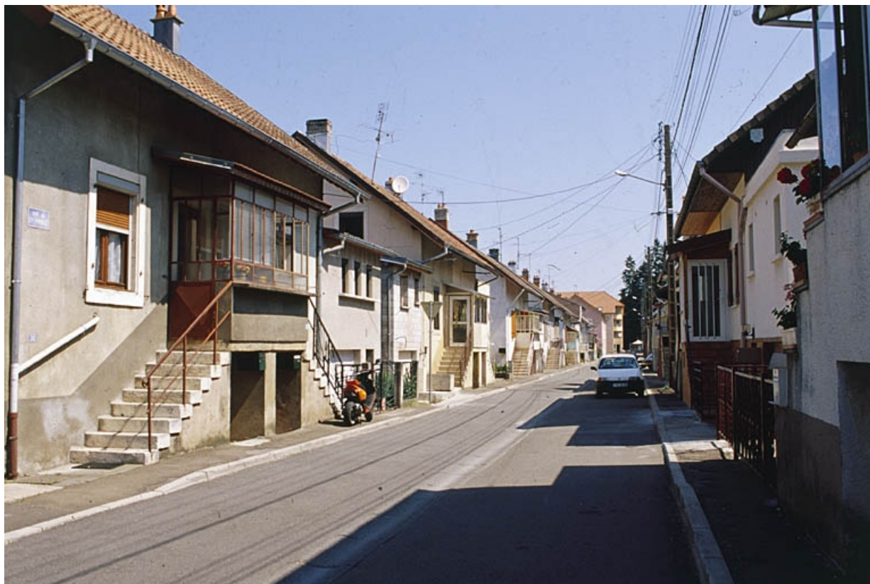
Logements ouvriers doubles rue du Commandant Prince.
