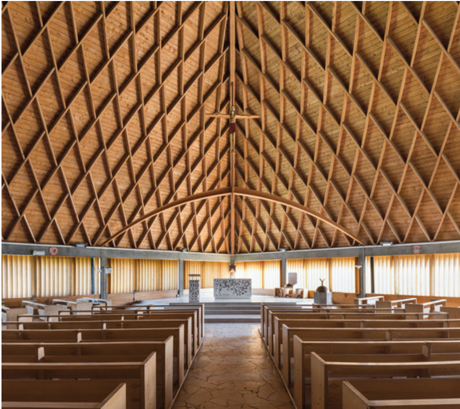
Chœur. Vue depuis l'allée centrale.
