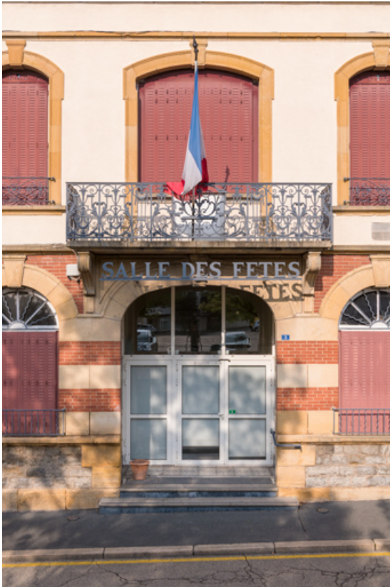
Façade antérieure : travée centrale.
