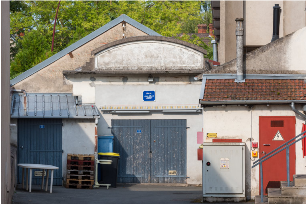
Garage en fond de cour, au nord-est.
