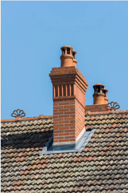
Hôtel-restaurant : souches de cheminée.
