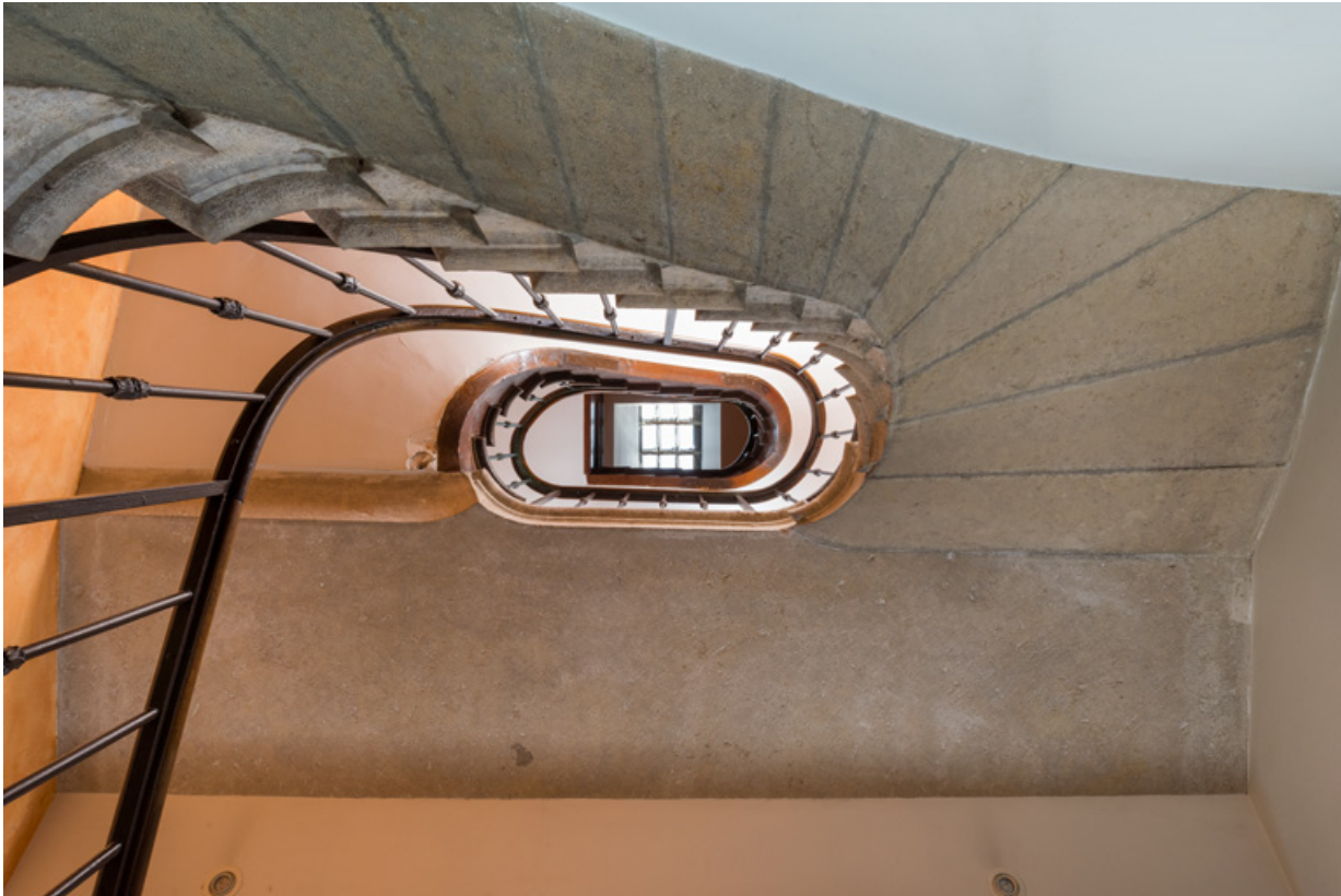
Mairie : escalier, vu en contre-plongée.
