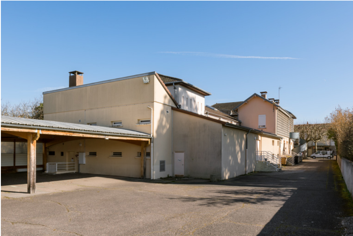
Vue d'ensemble, depuis les garages au sud-ouest.
