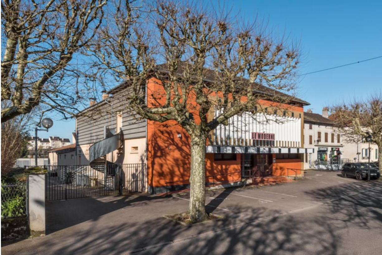
Vue d'ensemble, depuis l'avenue au sud-est.
