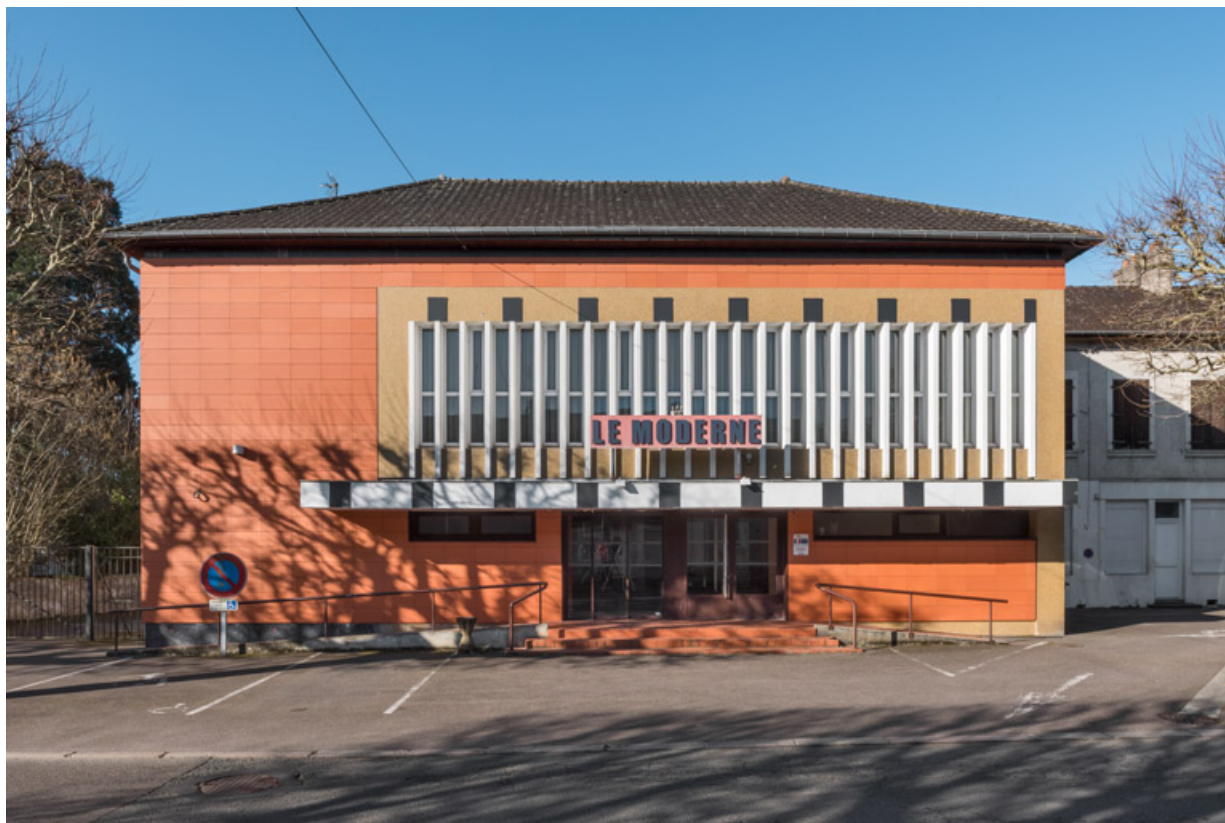
Corps d'entrée : façade antérieure.
