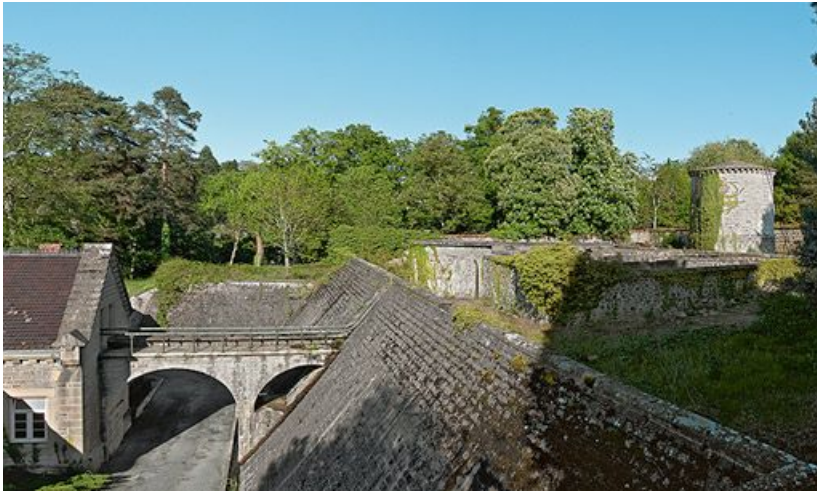
Château d'eau, réservoirs et pont-aqueduc.
