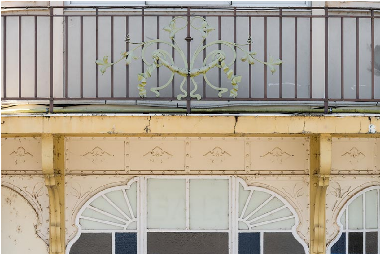
Aile ouest, salle à manger, détail.
