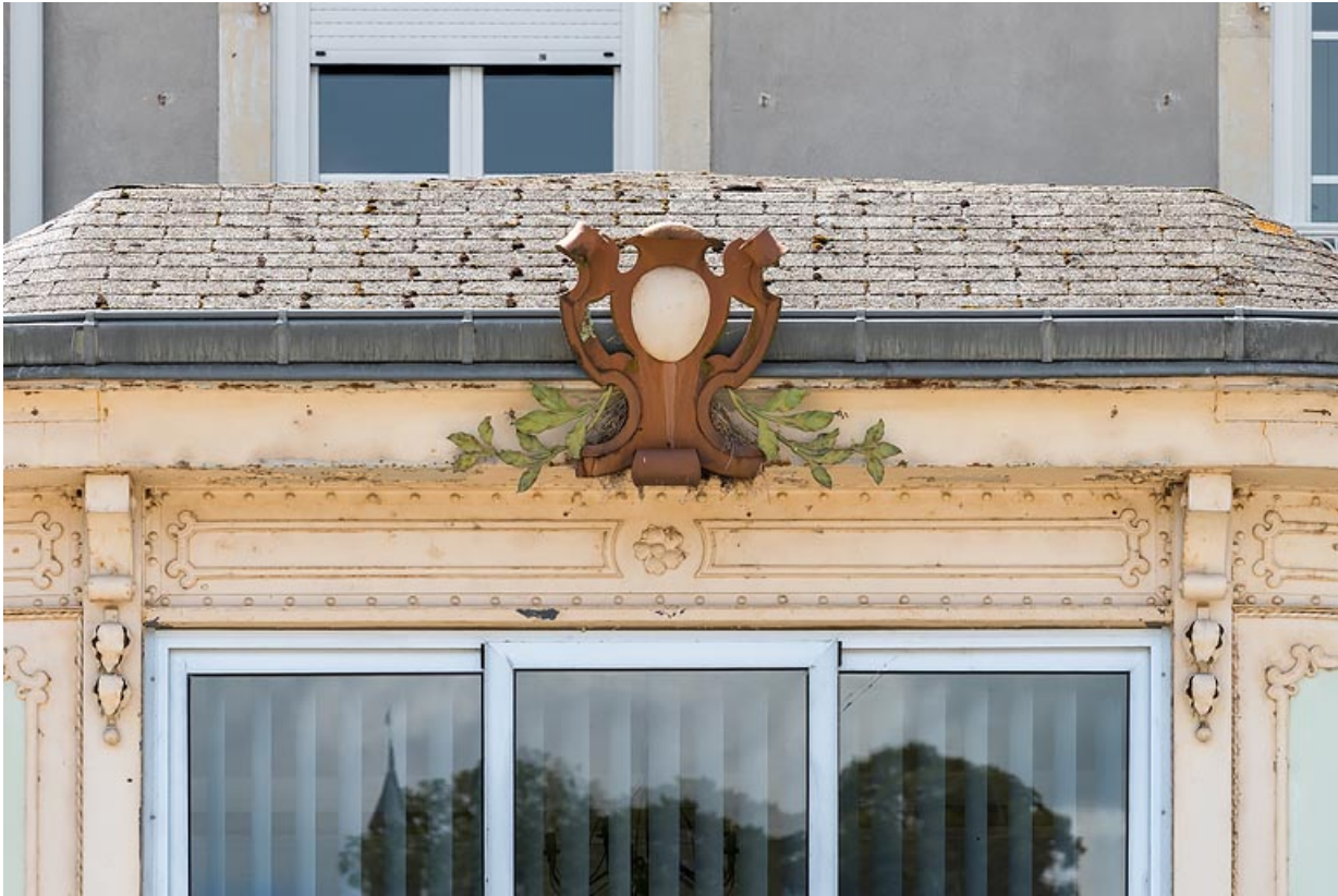
Aile ouest, salle à manger, détail.
