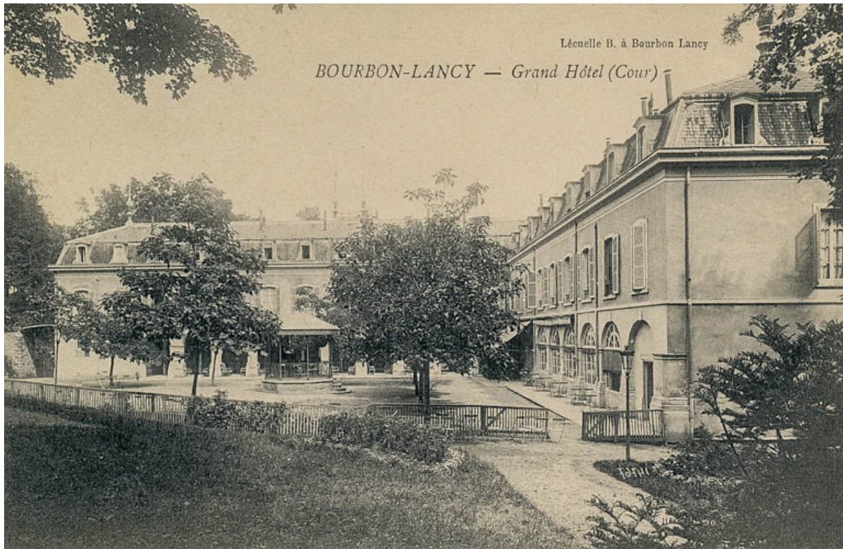
Cour, vue ancienne.
