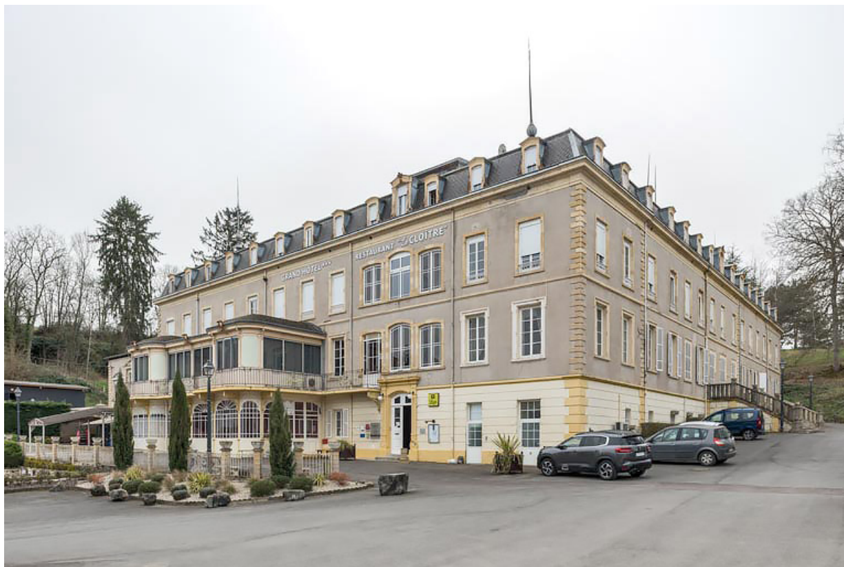
Aile ouest, vue d'ensemble.
