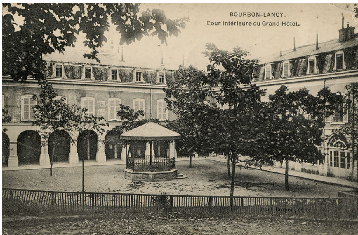
Cour, vue ancienne.
