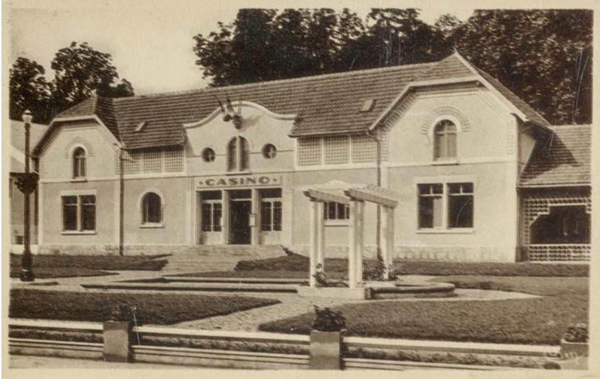
Façade sur la rue.
