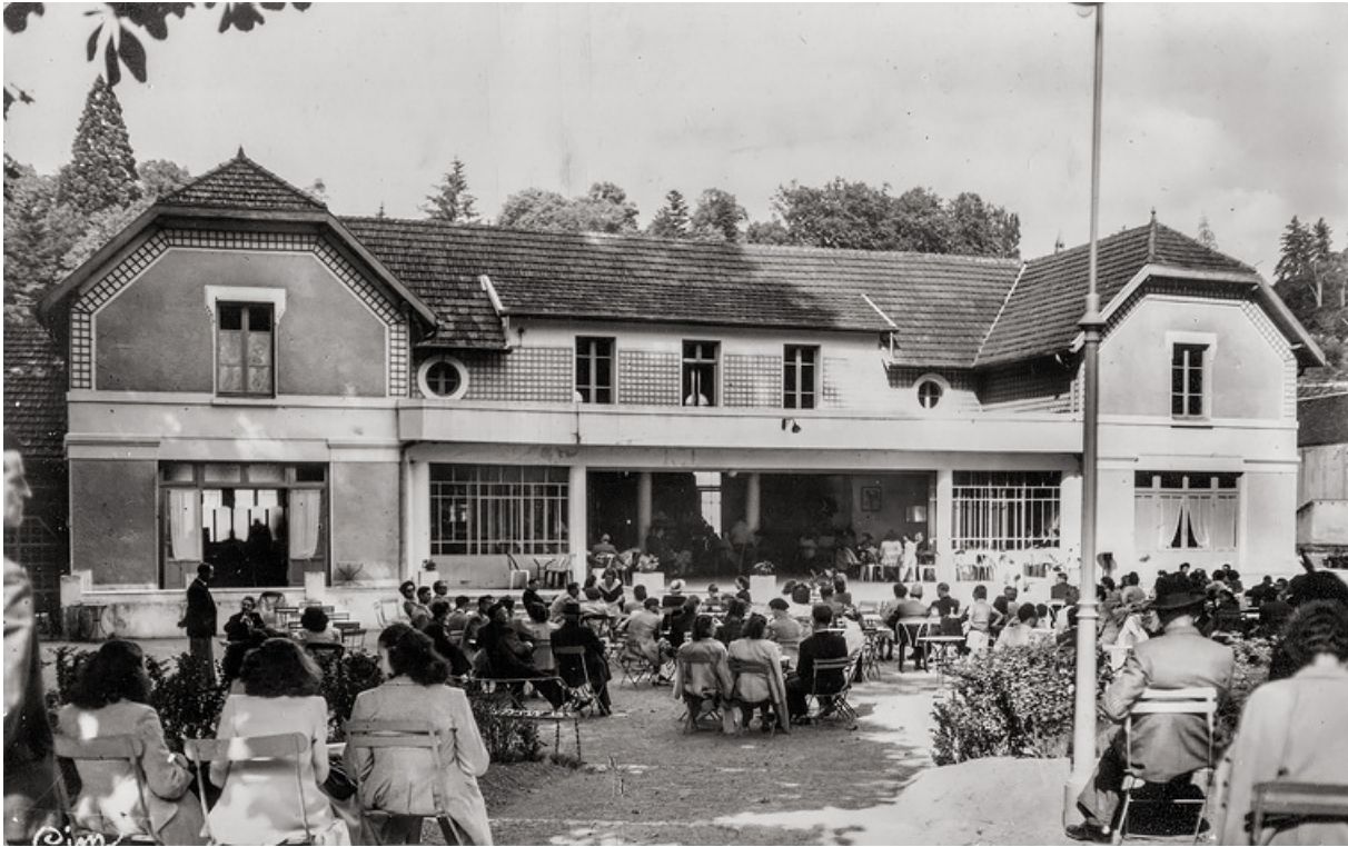
Façade sur le parc.
