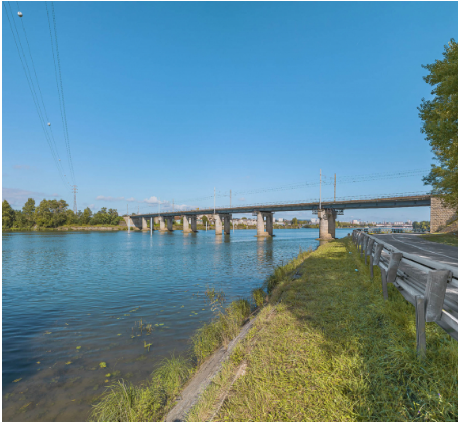
Le pont vu d'aval, rive gauche.
