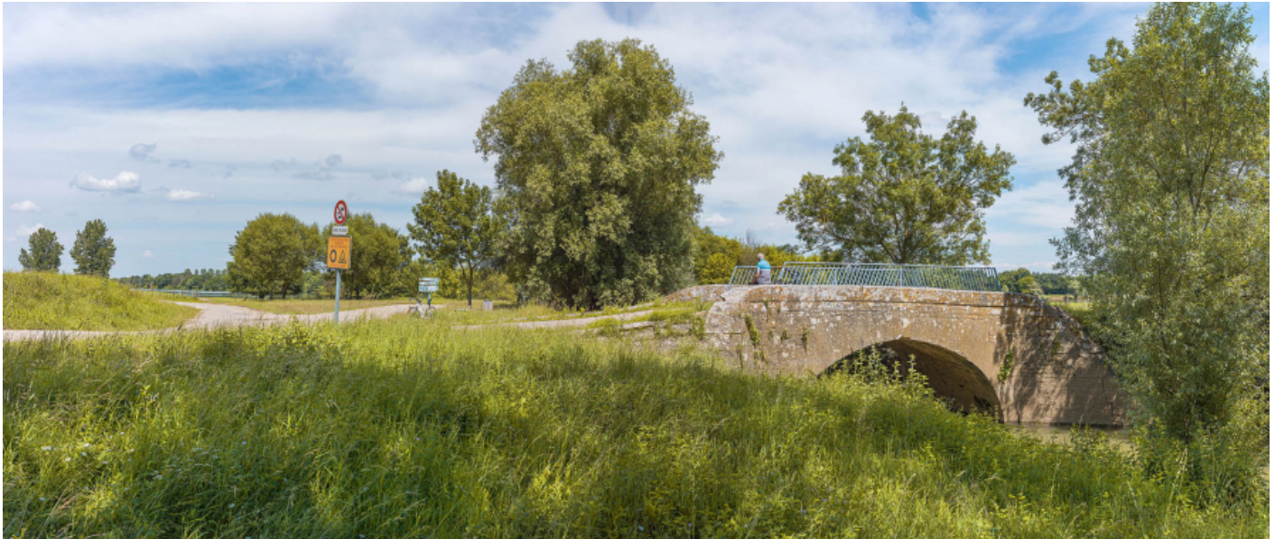
Le pont sur la Mouge, rive droite.
