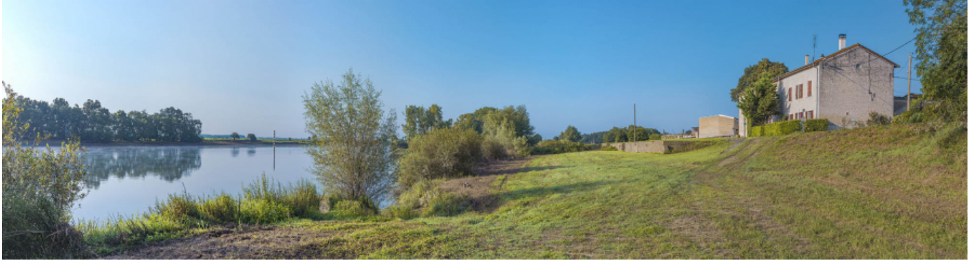
Le port de Farges : mur de soutènement.
