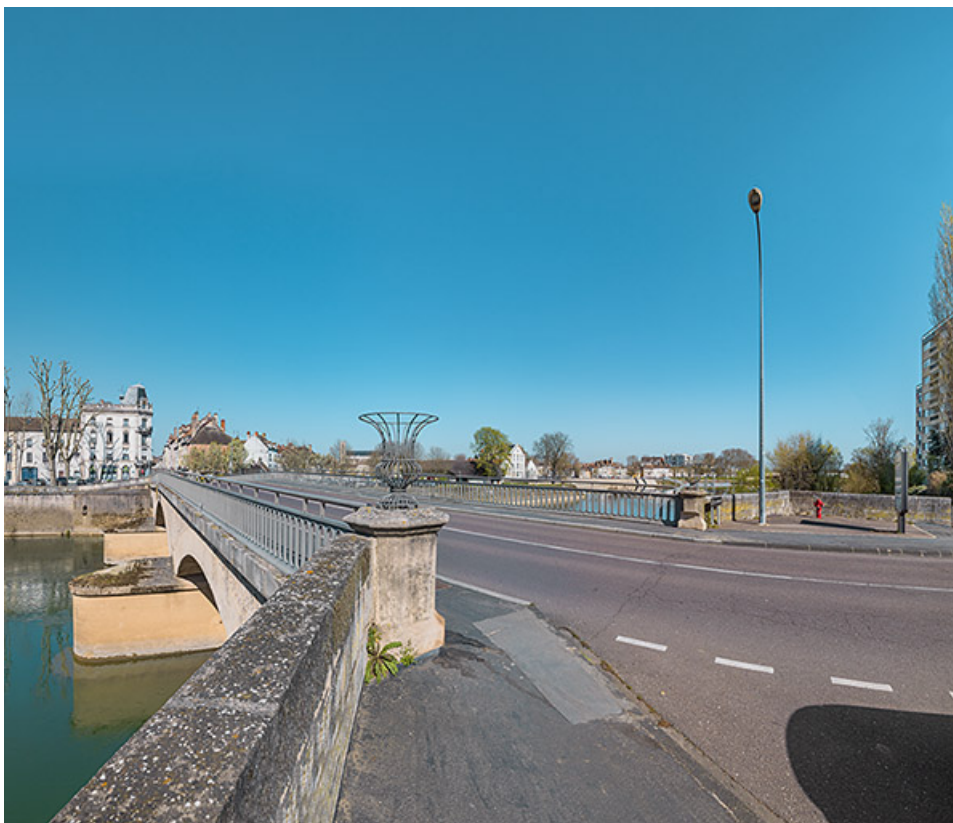
Vue d'ensemble du pont depuis la chaussée.
