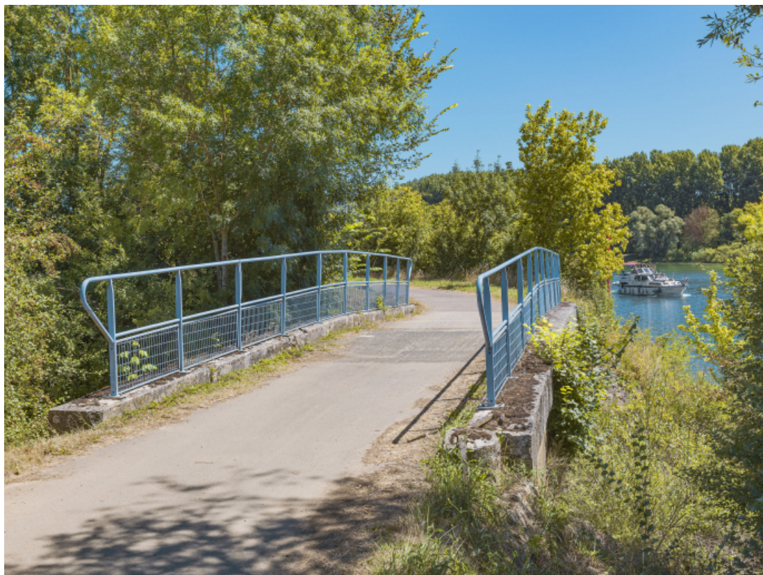
Vue d'ensemble du pont, d'aval.
