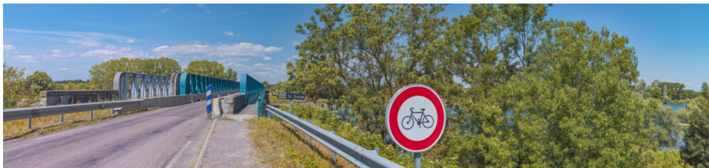
Le pont mixte de Chauvort : à gauche, la voie ferrée désaffectée et à droite, la voie routière et piétonne.
