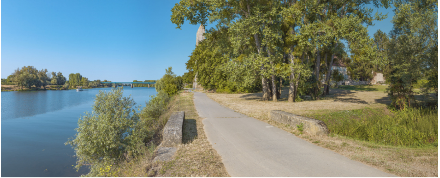
La digue de Chauvort, vue d'amont.
