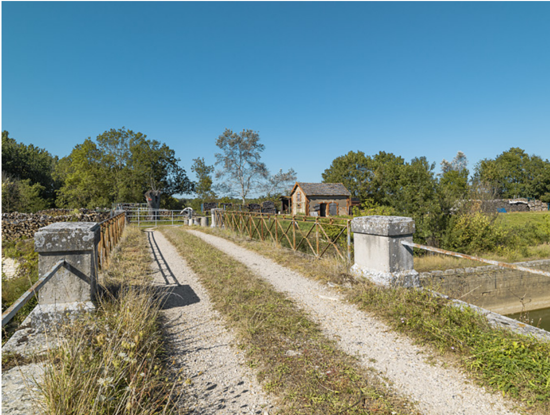
Vue d'ensemble du pont sur l'écluse.
