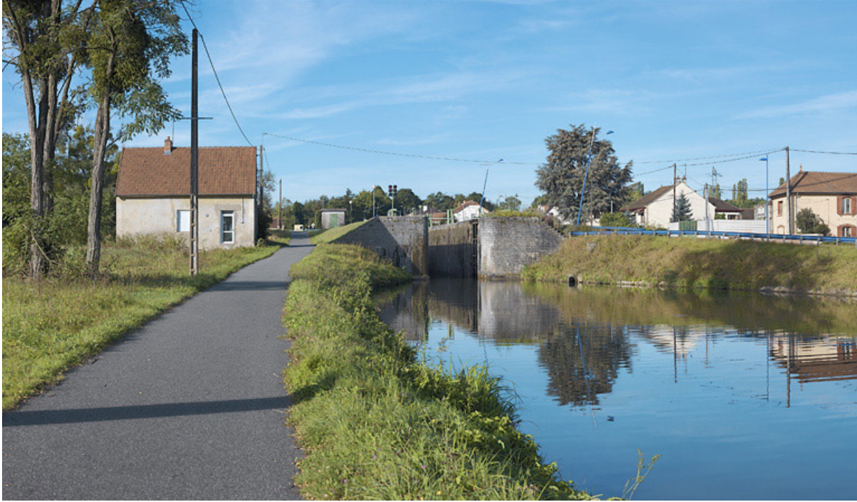
Site de l'écluse 02 depuis le bief 03.
