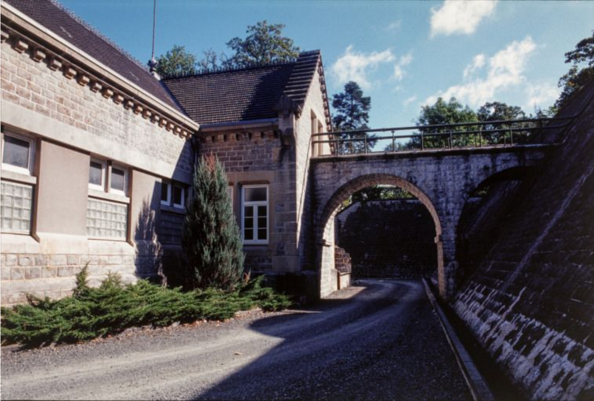
Elévation postérieure et pont-aqueduc.
