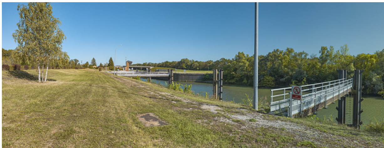
Le site d'écluse vu d'aval.
