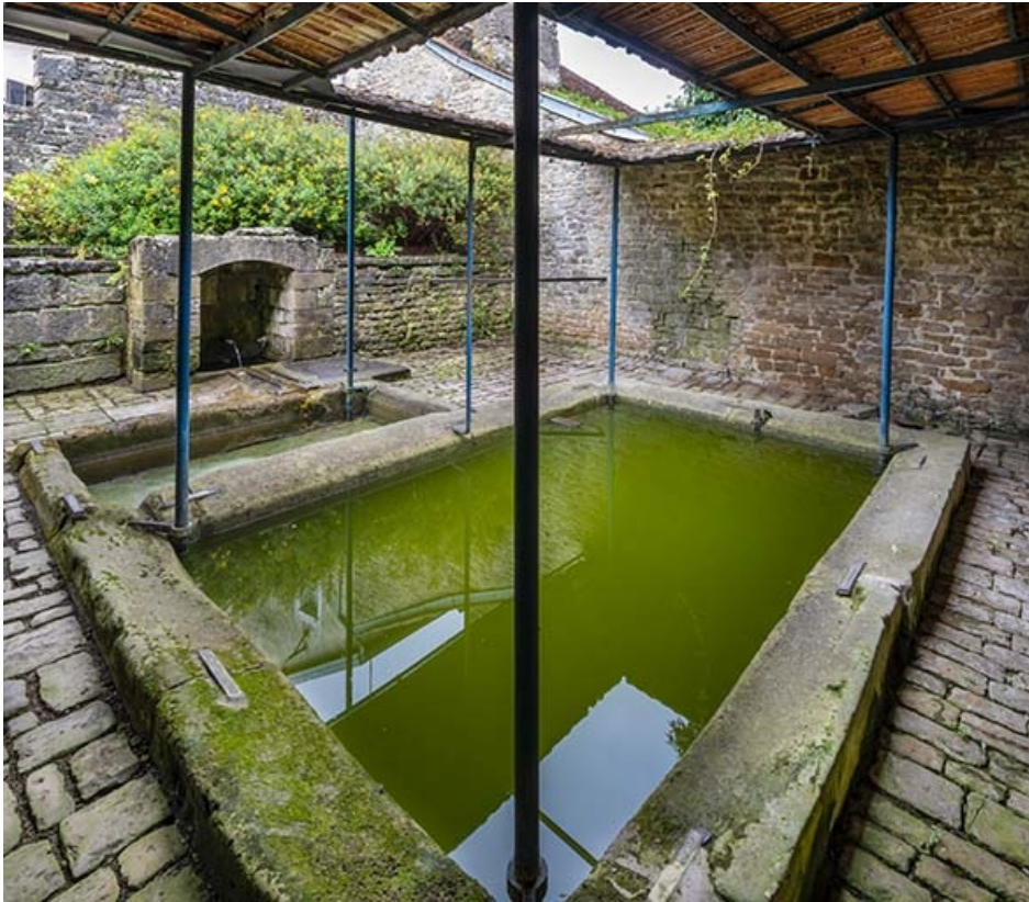
Vue intérieure des bassins.
