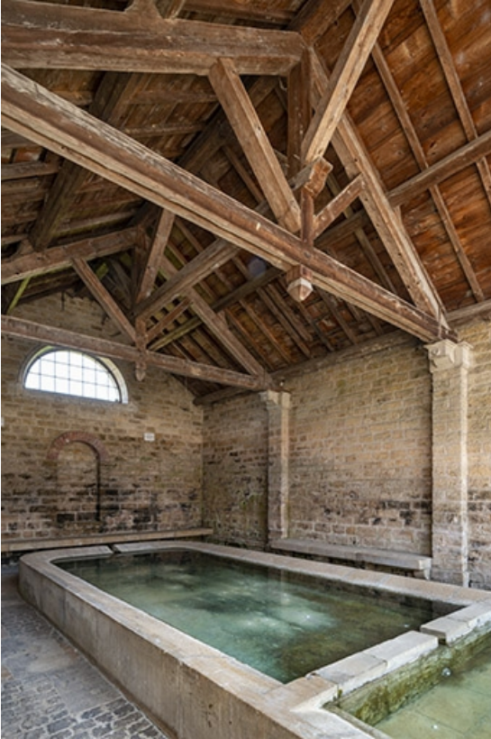
L'intérieur du lavoir, depuis l'entrée.
