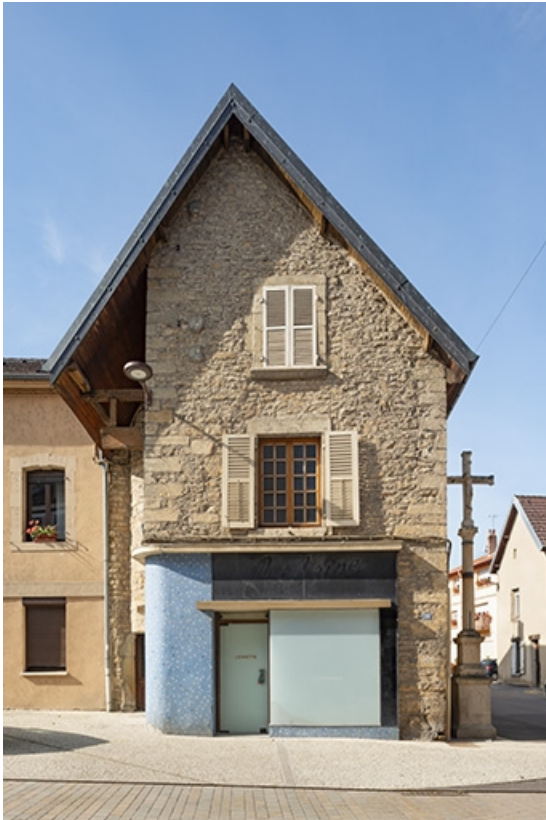
Le pignon depuis la rue Gambetta.
