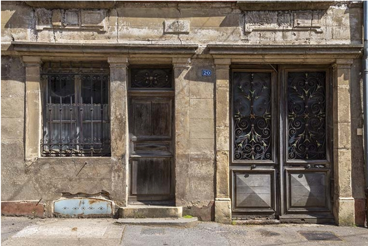
Pilastres, ferronnerie, menuiserie, bas-relief sur la façade.
