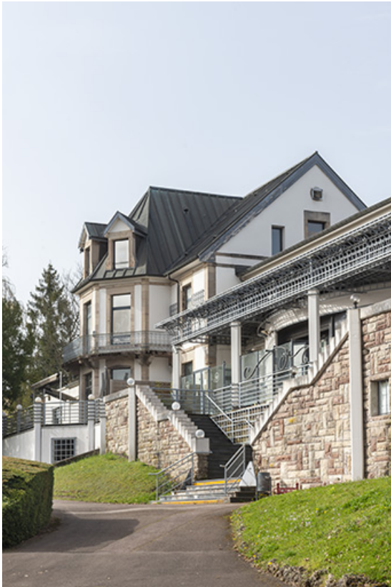
Maison, vue depuis le nord.
