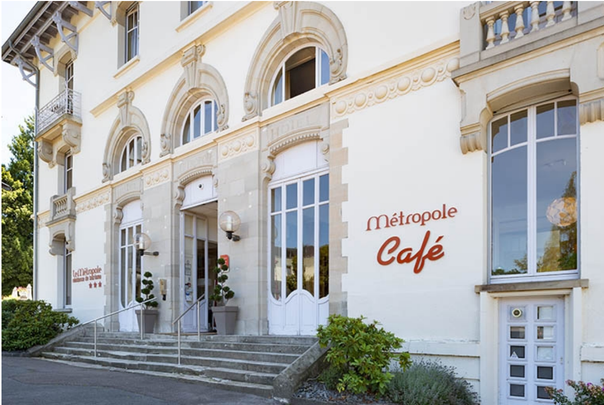
Façade nord, vue de trois quarts, détail.
