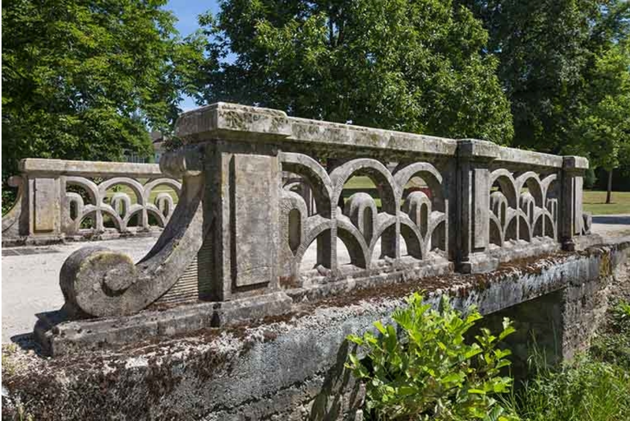
Pont à garde-corps en pierre.
