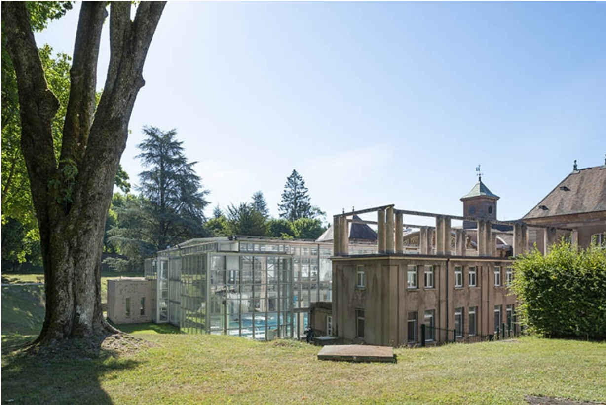
Vue en direction de l'établissement thermal.
