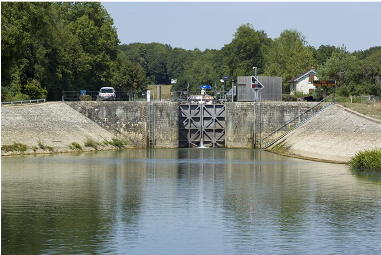
Vue aval, avec les perrés maçonnés.
