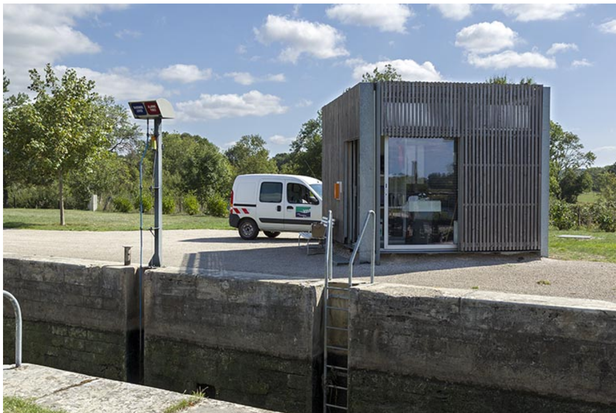
Poste de commande.
