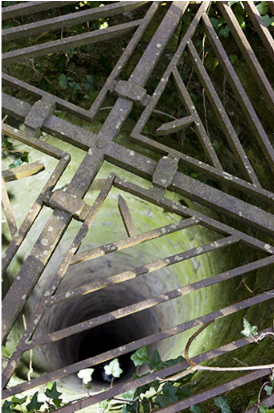
Vue du puits depuis l'orifice.
