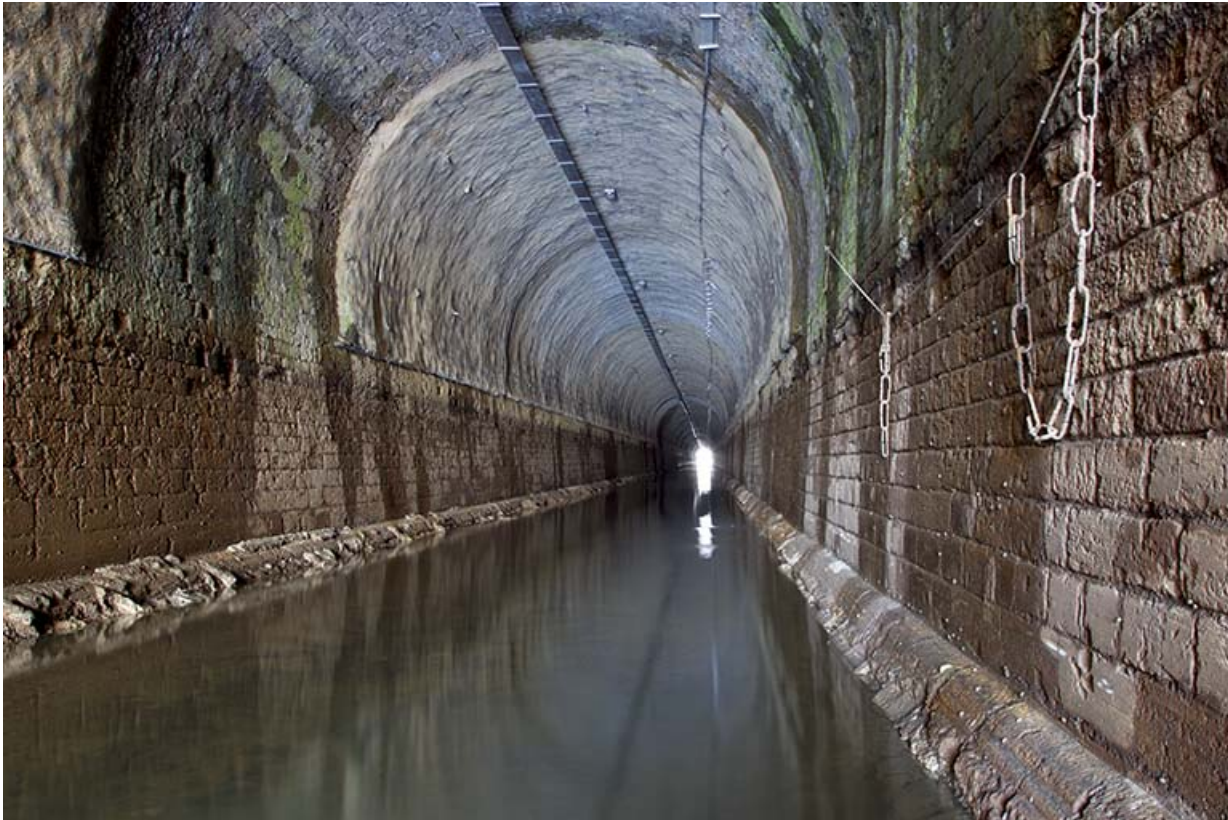
Intérieur du tunnel, vue générale.
