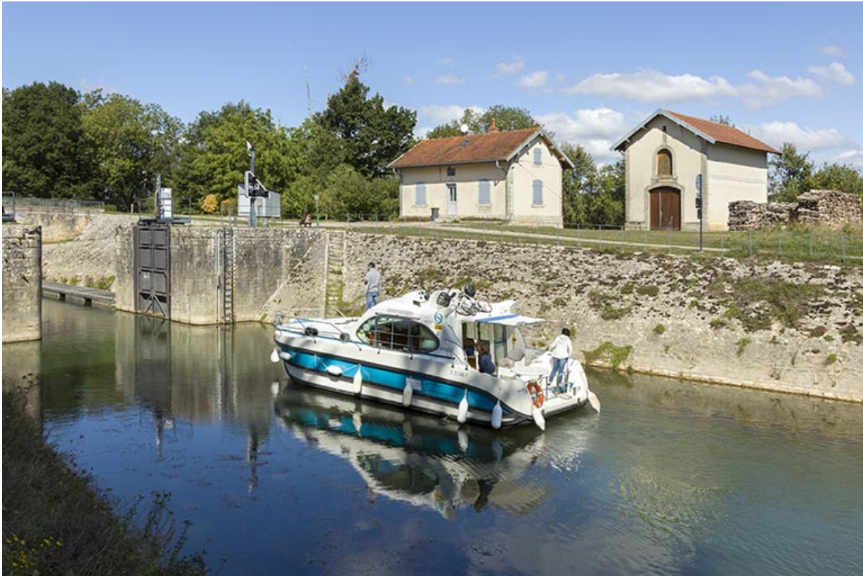
Ecluse de Ferrières-lès-Ray.
