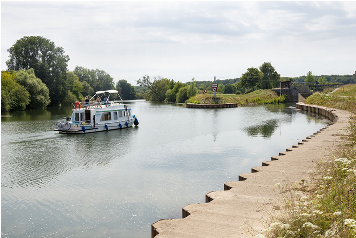
Entrée du canal de navigation de Cubry.
