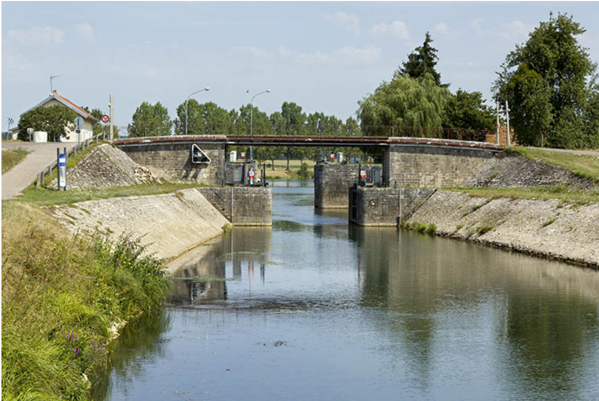
Entrée aval de l'écluse.
