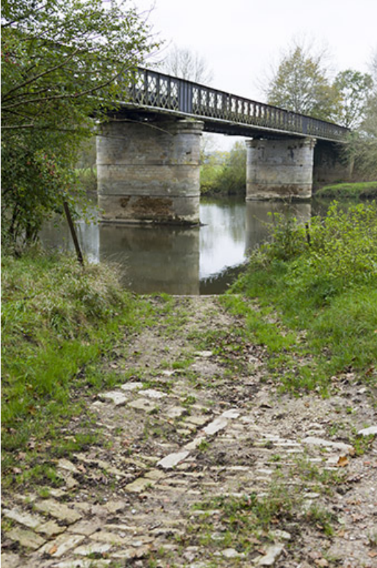
Emplacement de l'ancien bac de Cubry.
