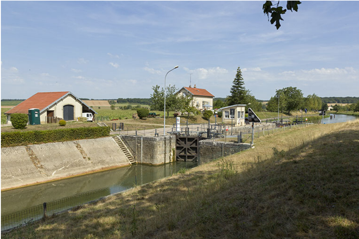
Vue générale du site d'écluse.
