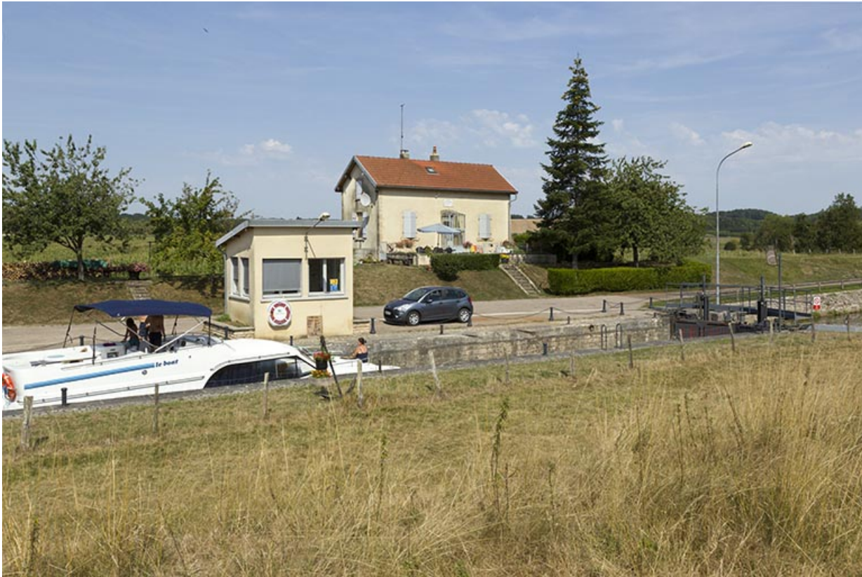
Bateau en train de franchir l'écluse.
