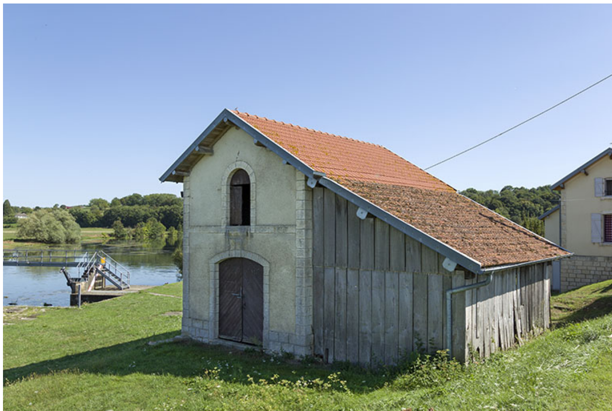
Magasin à aiguilles du barrage.
