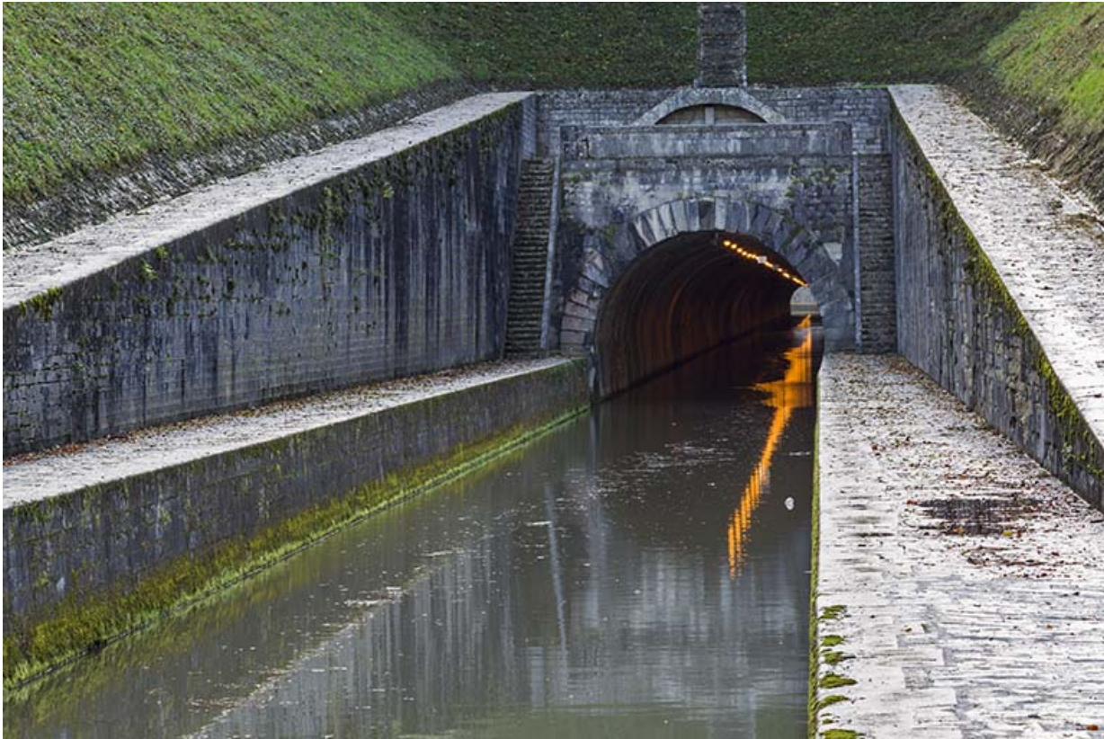
Le tunnel de Saint-Albin.
