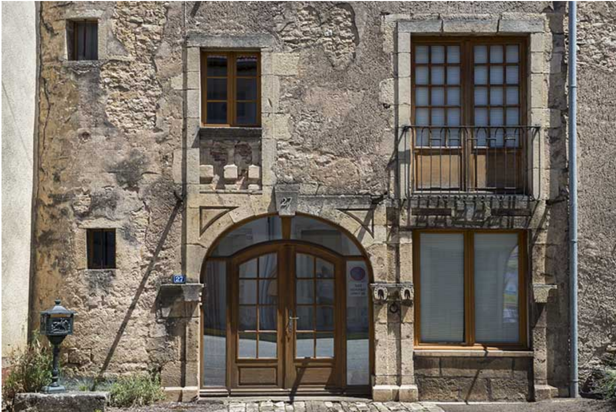
Baies du rez-de-chaussée et du premier étage.
