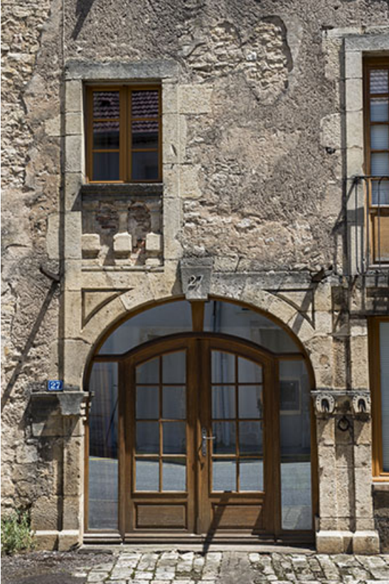
Baies du rez-de-chaussée et du premier étage.
